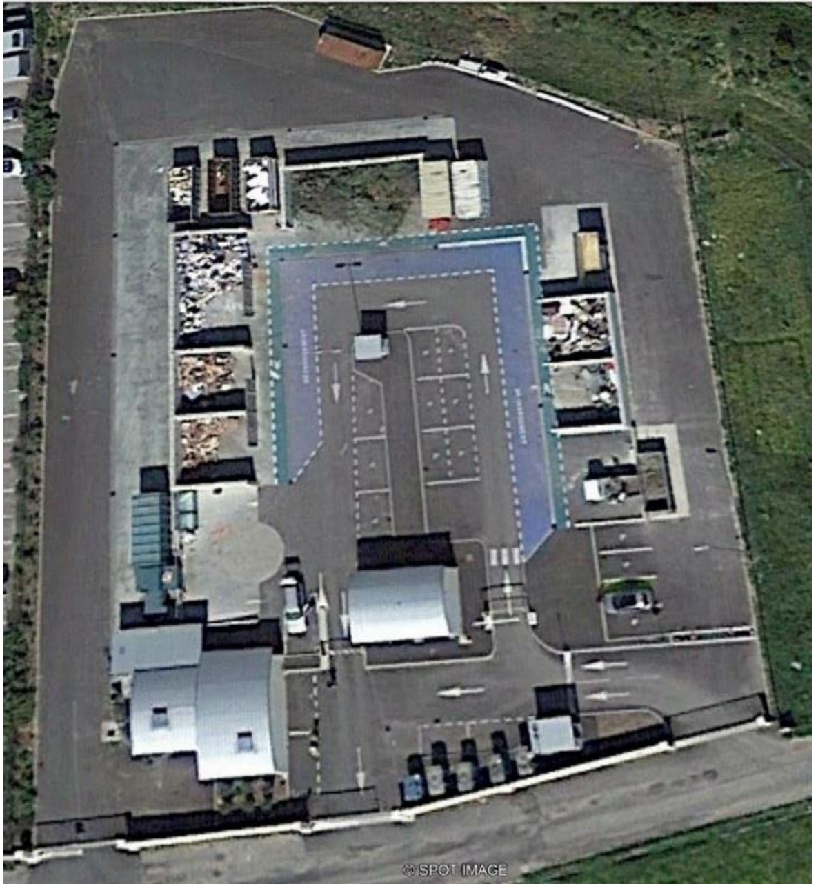
Figure 5 bis : Vue aérienne de la déchèterie de Gignac
