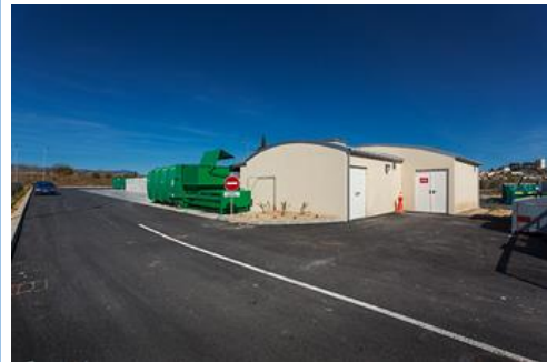
19. Accès de service aux casiers
