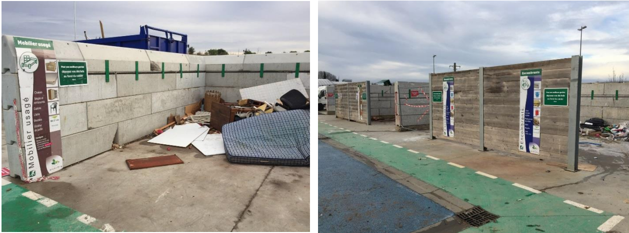
Figure 8 : Photos des casiers de la nouvelle déchèterie de Gignac
